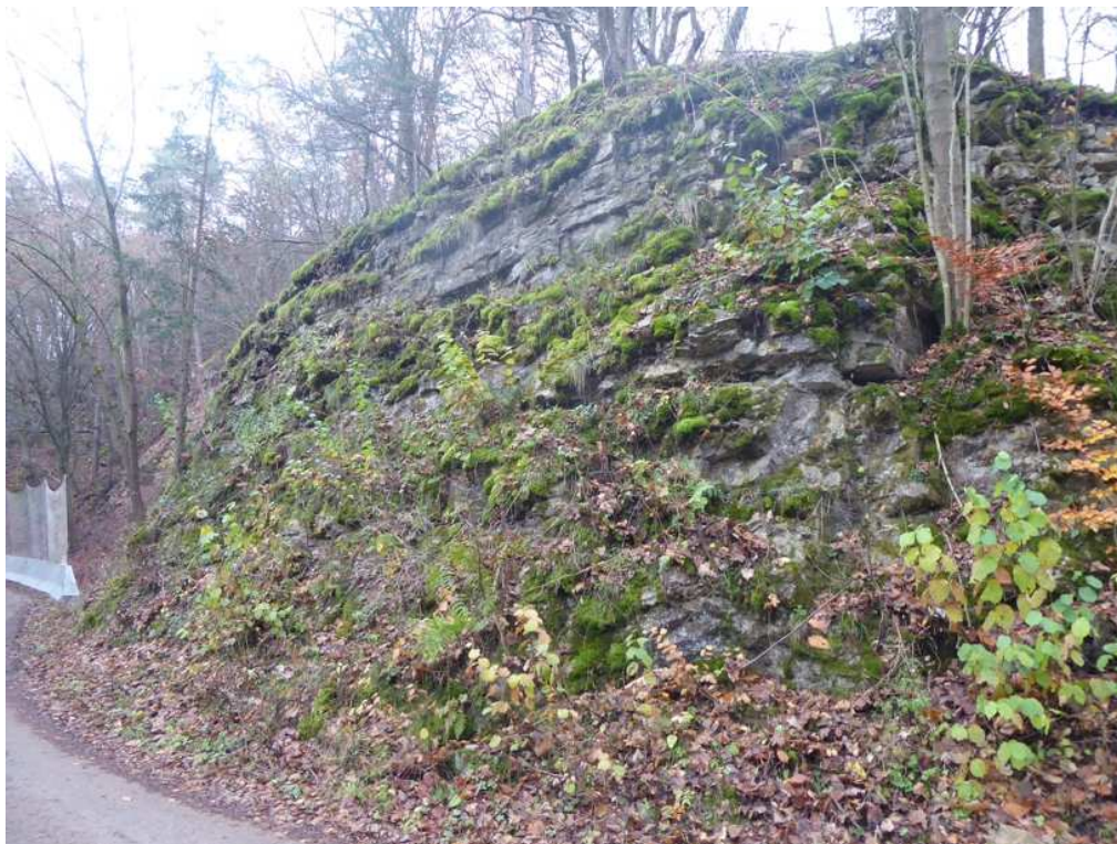
Část skal. svahu, kt. bude po očištění a odstr. náletu, zajištěna ocel. sítěmi.
