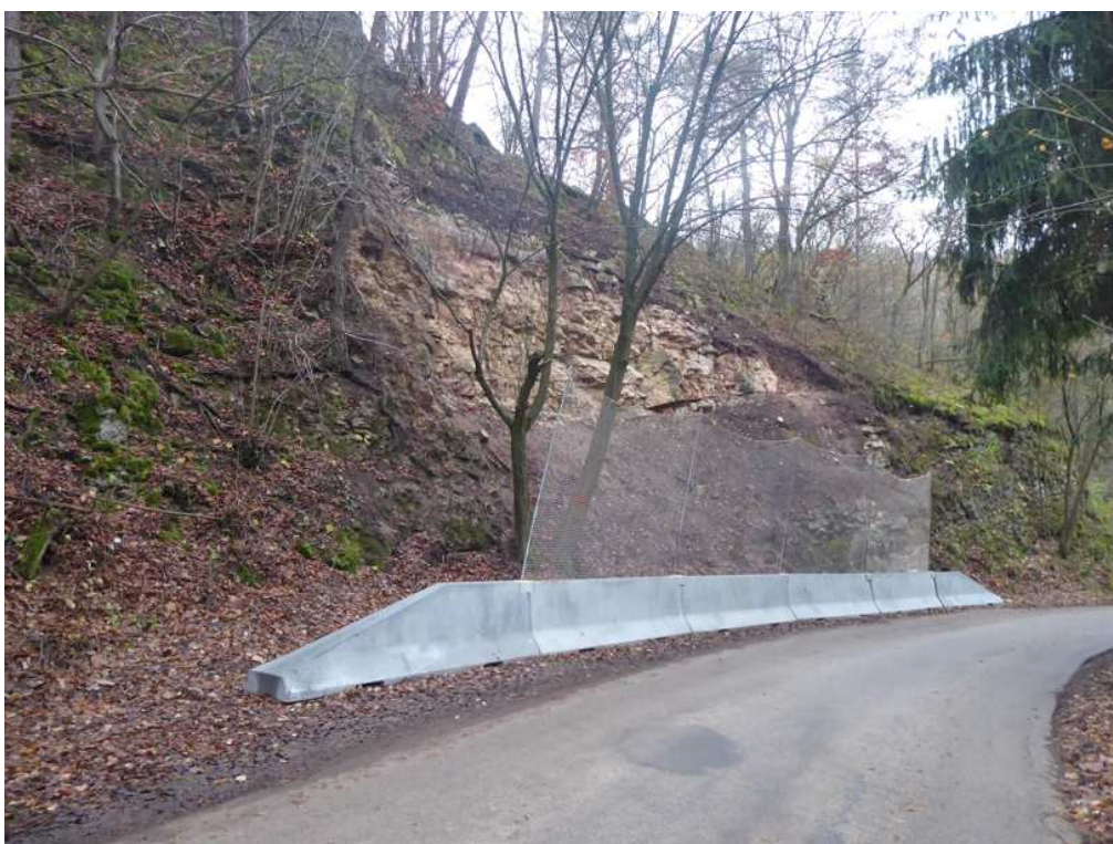
Přibližně v linii bet. svodidel bude instal. palisáda s dřev. výplní v. 1,5 m.
