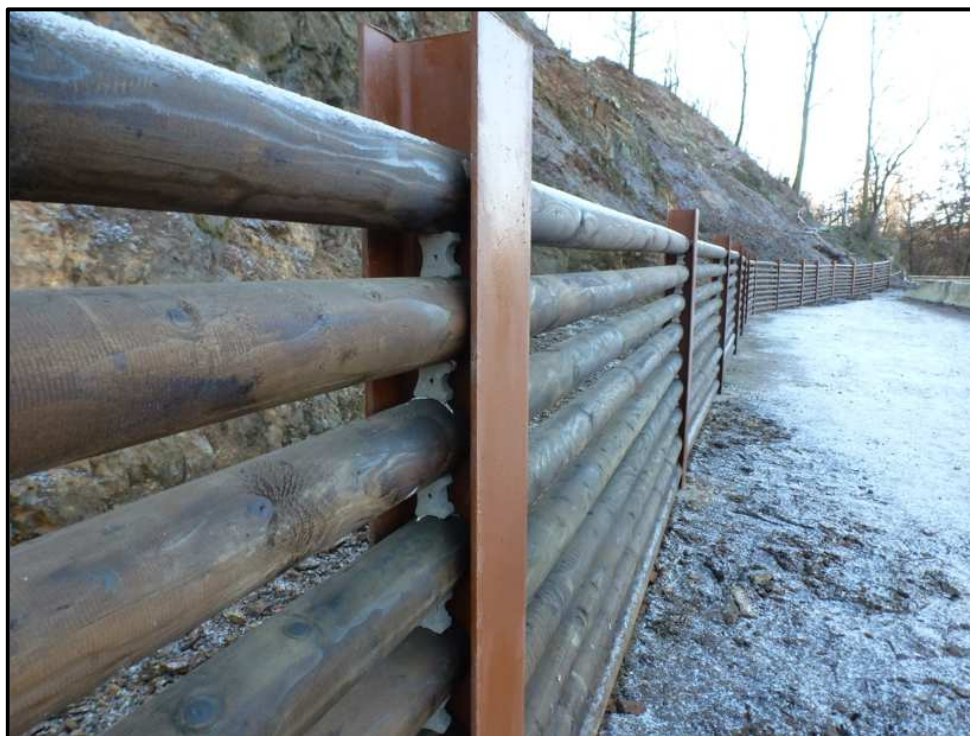
Obr. č. 2 – Příklad podélného distancování dřevěné kulatiny podložkami.
