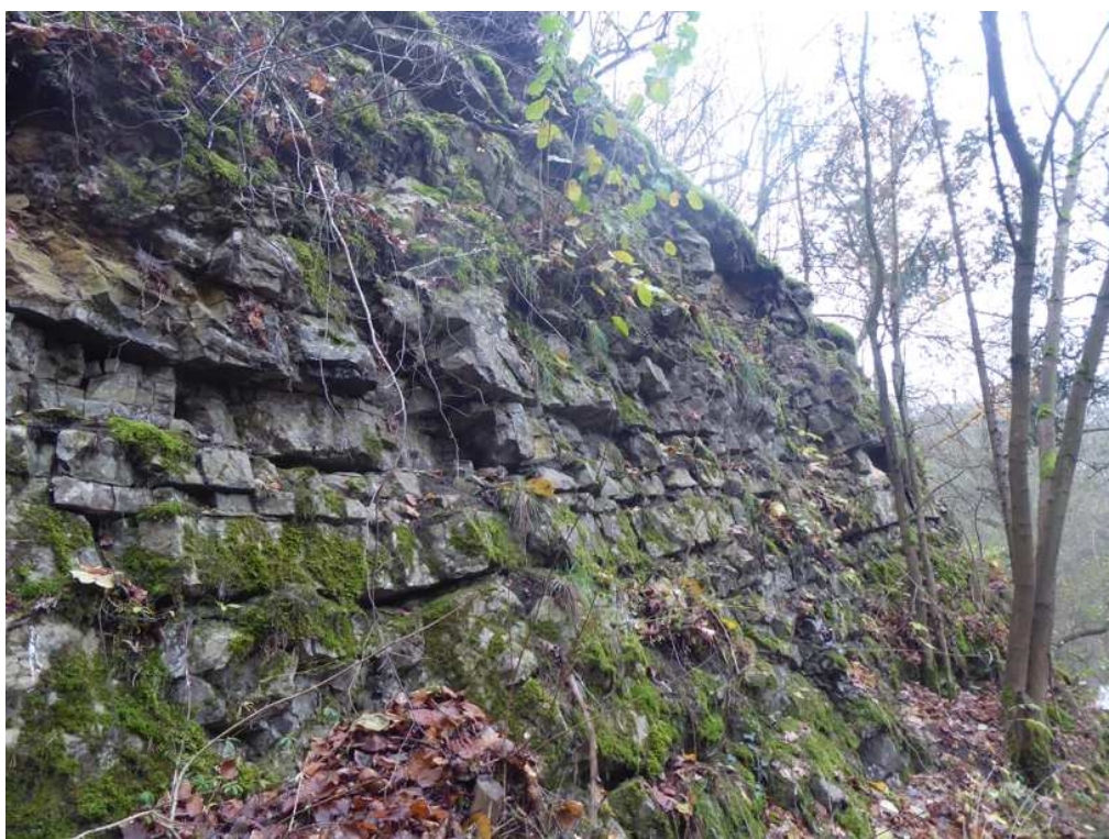
Detailní pohled na stav zvětrání horniny, kt. opadává do prostoru silnice.
